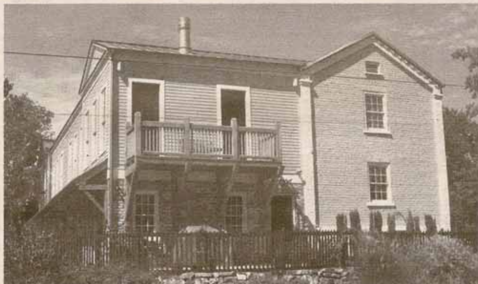
Edificio reconstruido por la firma H&G Construction Concepts LLC.
